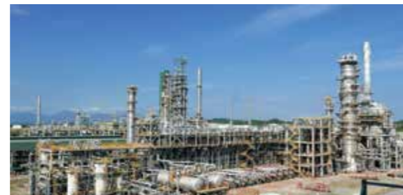
NHÀ MÁY LỘC DẦU | 2010, QUẢNG NGÃI
