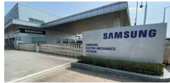
NHÀ MÁY SAM SUNG | 2015, THÁI NGUYỄN
